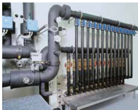
Rozdělovač primárního okruhu.
