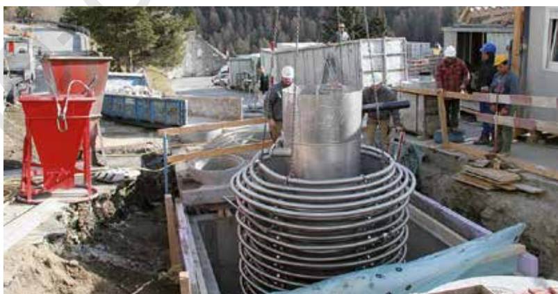
Tato šachta na odpadní vodu slouží jako primární zdroj k úpravě teplé vody.
