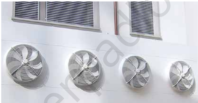
Glykolový zpětný chladič jako řešení s integrováním do fasády pro tepelná čerpadla vzduch/voda.
