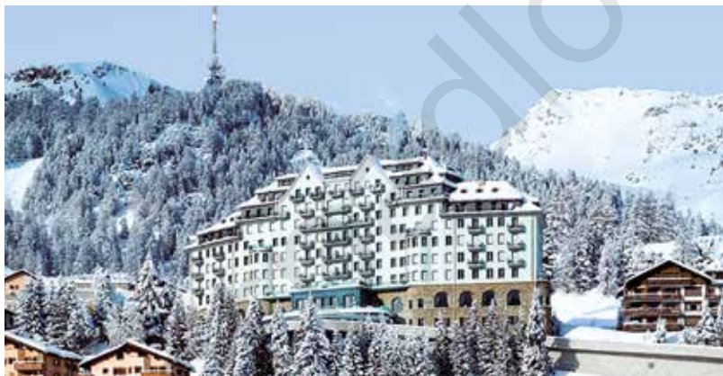
V pětihvězdičkovém hotelu Ritz Carlton v St. Moritz se odpadní voda využívá k získání tepla.
